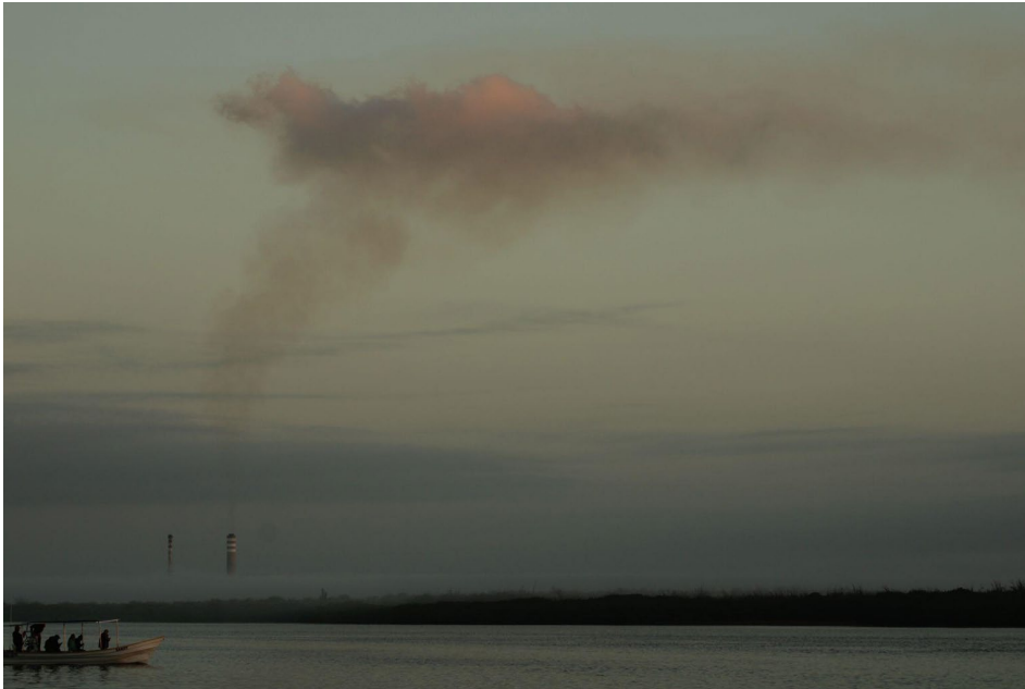
Fotografía 3. La central eléctrica desde la perspectiva de los pescadores
