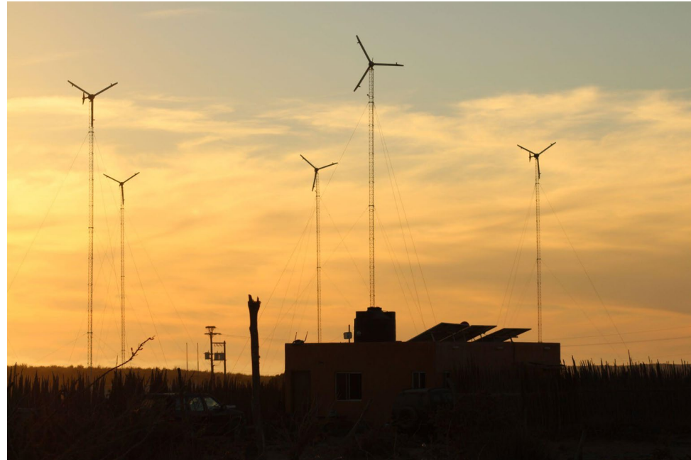
Fotografía 2. La central Eléctrica desde la perspectiva de los pescadores
