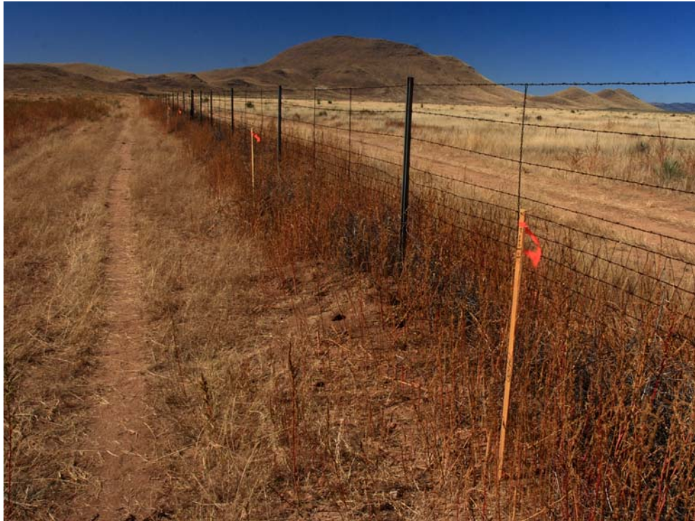
Figura 18. Inicio de la construcción de la barrera fronteriza en el cruce fronterizo de El Berrendo – Antelope Wells. En la foto, tomada del lado de Estados Unidos, se observan las marcas colocadas por los topógrafos para delimitar el sitio donde se va a instalar la infraestructura fronteriza. En el momento de tomar la foto las banderas se extendían 5 km al este y 5 km al oeste del cruce fronterizo de El Berrendo – Antelope Wells (Foto: Eduardo Ponce).
