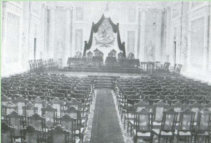
Salón de sesiones, instalado en el Salón de Actos de la Escuela de Minería. Fotografía del Fondo Gustavo Casasola.
