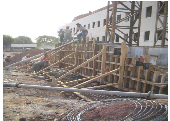
Colocación de concreto para construcción de muro en acceso de plaza oriente
