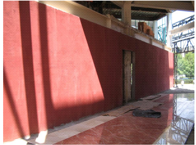
Detalle de colocación de mármol en piso y acabado de pasta en muro
