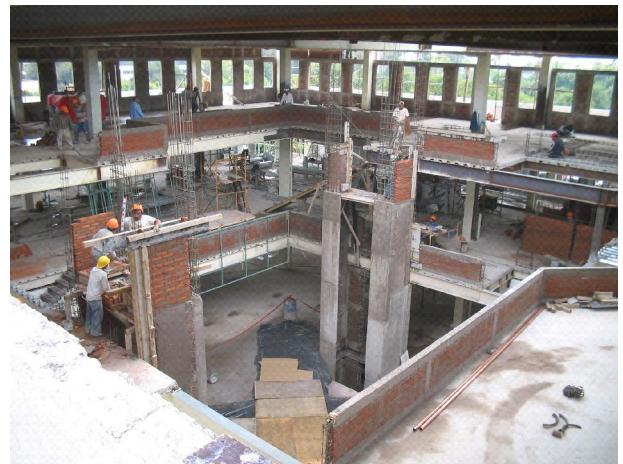
Muros de tabique en el perímetro de la plaza central, y en fondo el cubo de elevadores
