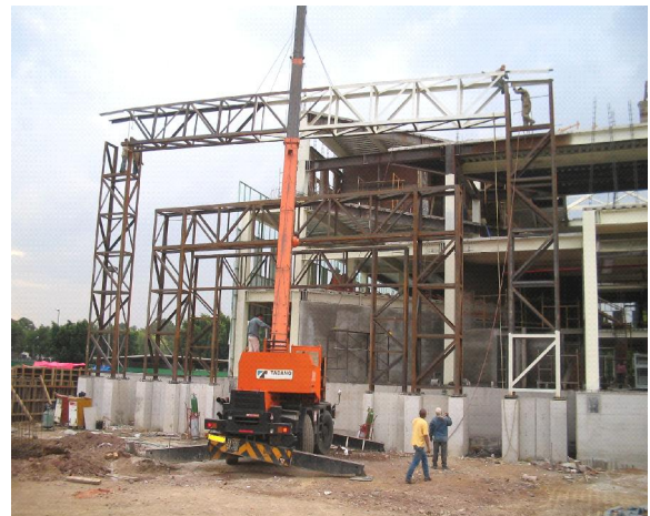
Montaje de estructura metálica del marco de acceso
