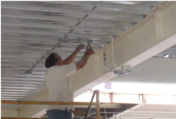
Conexión de tubo para instalación eléctrica de contactos
