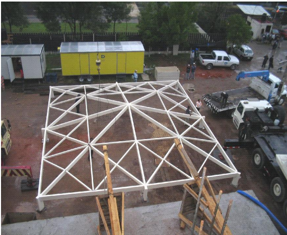
Vista de la construcción de domo piramidal
