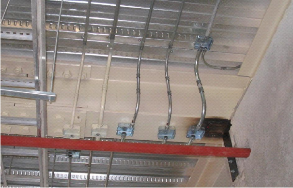
Detalle de la colocación de cajas para sistema de alumbrado
