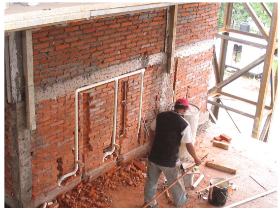
Trabajos de instalación sanitaria en área de baños
