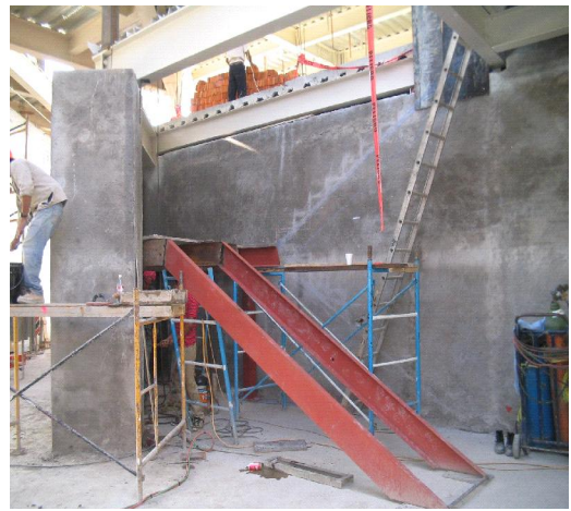
Construcción de escalera metálica
