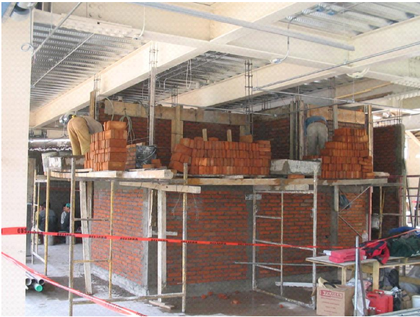
Construcción de muros en la zona de baños
