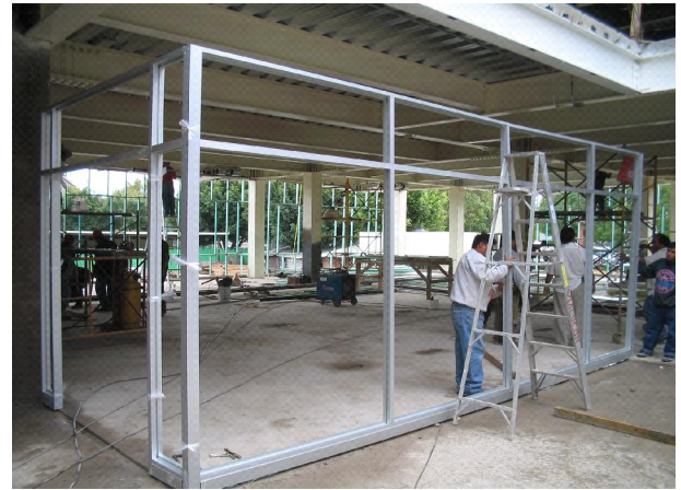
Colocación de cancelas de aluminio en planta baja
