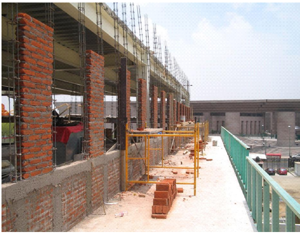
Construcción de muro perimetral en terraza
