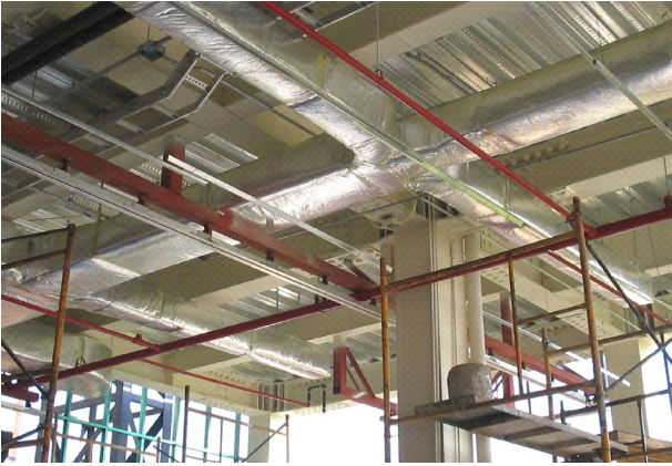
Vista de los ductos para aire acondicionado
