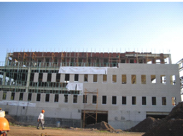
Vista parcial del avance de la colocación de fachada prefabricada a base de muros plycem
