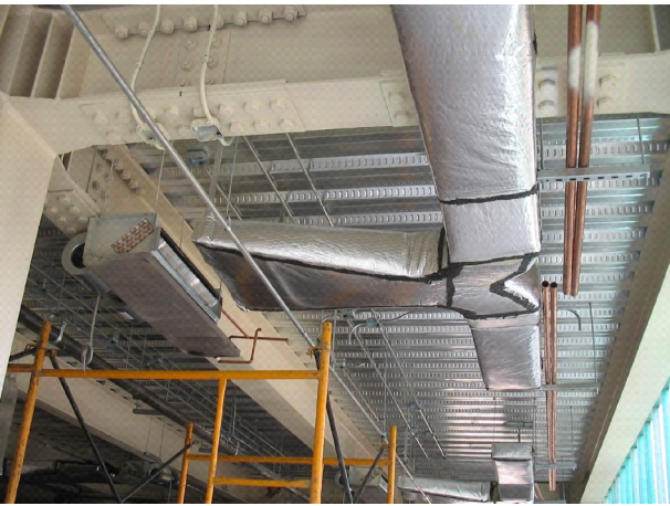
Instalación de aire acondicionado
