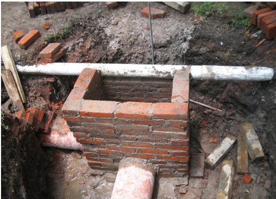
Construcción de registro del sistema de alcantarillado
