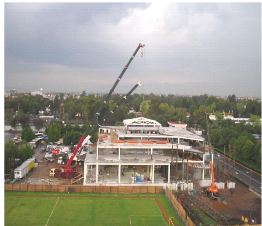
Maniobras de montaje del domo piramidal
